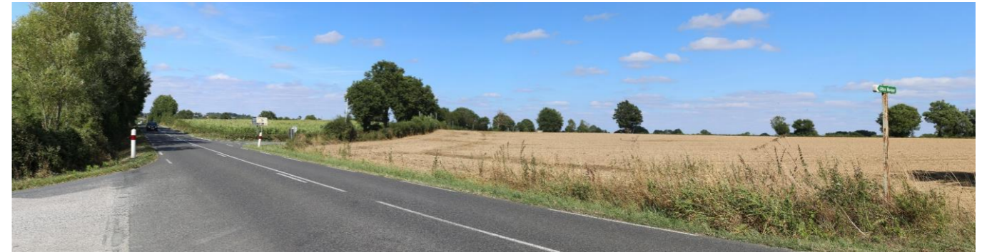
Photo 39 : Depuis la RD744, des vues semi-lointaines s'ouvrent en direction des ZIP, à peine tronquée par la végétation bocagère (Source : AEPE-Gingko, 06/08/2019)
