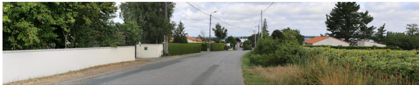
Photo 23 : Vue en direction des ZIP depuis l'entrée sud de Largeasse, via la RD140 (Source : AEPE-Gingko, 06/08/2019)
